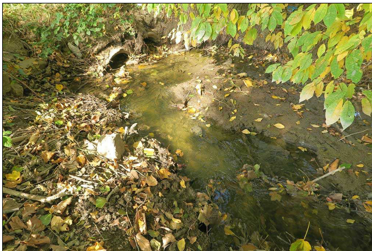
Obrázek 27: Nánosy sedimentů zabraňují průtoku propustků pod mostkem v dolním úseku toku Dlouhé Strouhy (9.10.2018).
